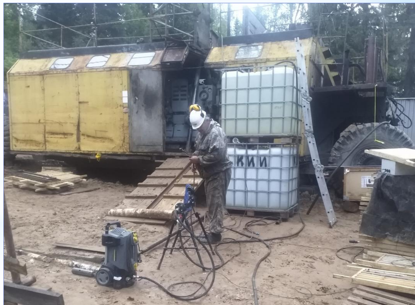
Обустройство устья скважины при проведении инжект-теста
