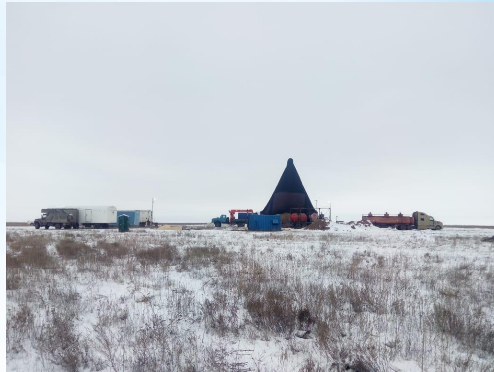
Полигон на участке Карпенский (Саратовская область)
