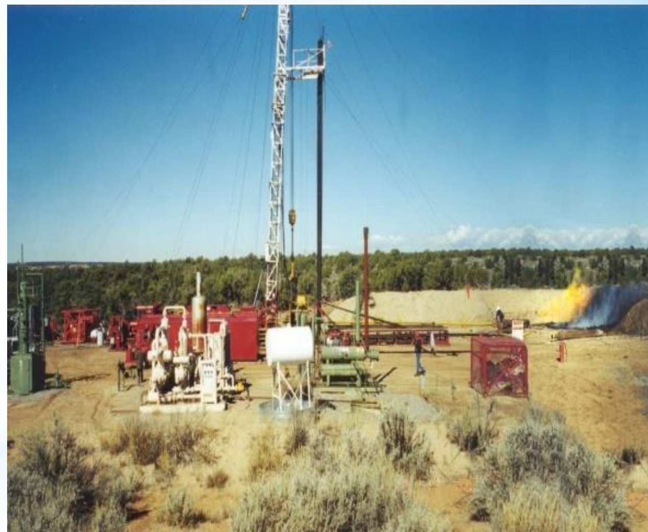
Площадка метанодобывающей скважины Сан-Хуан
