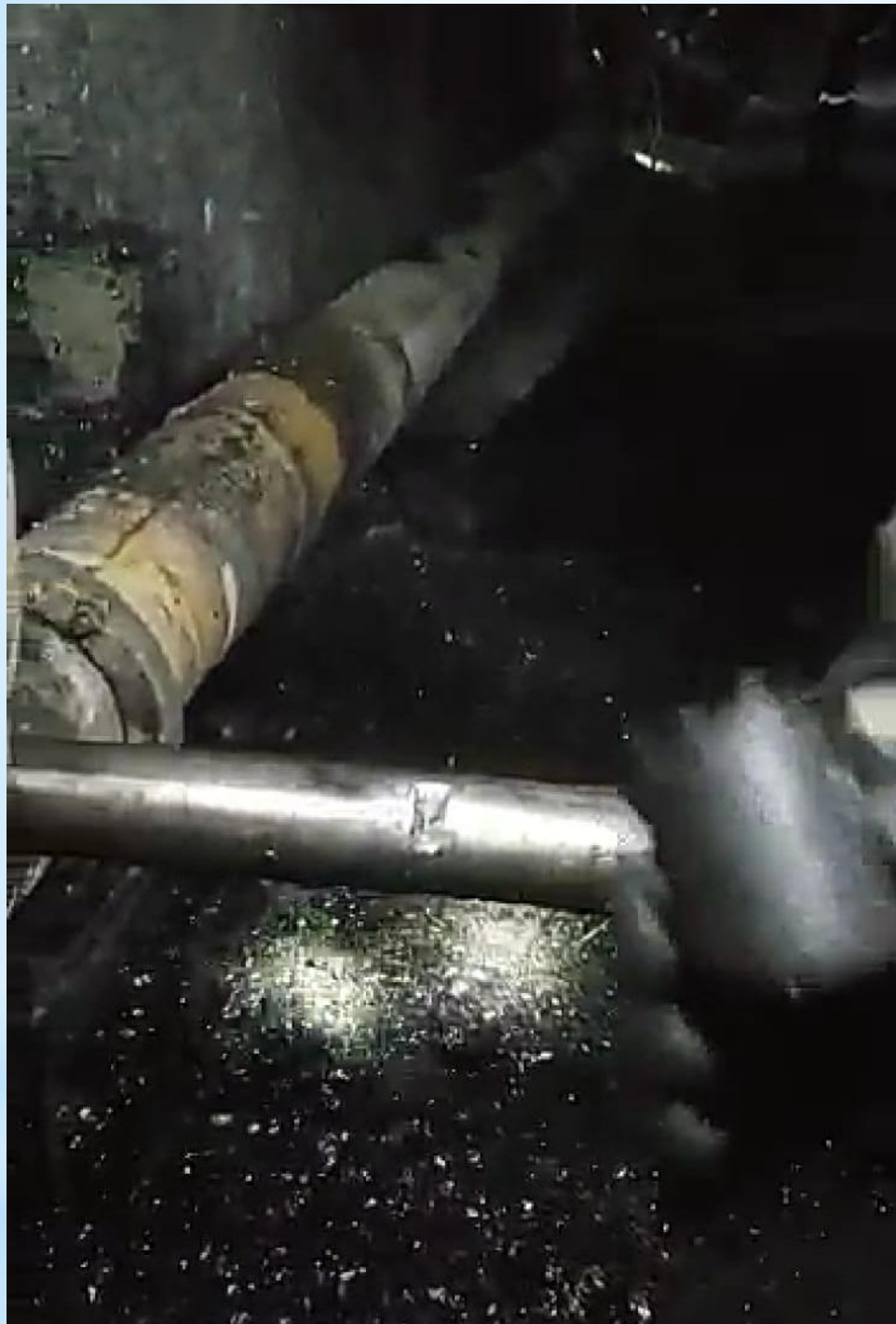
Бурение скважин из горных выработок
