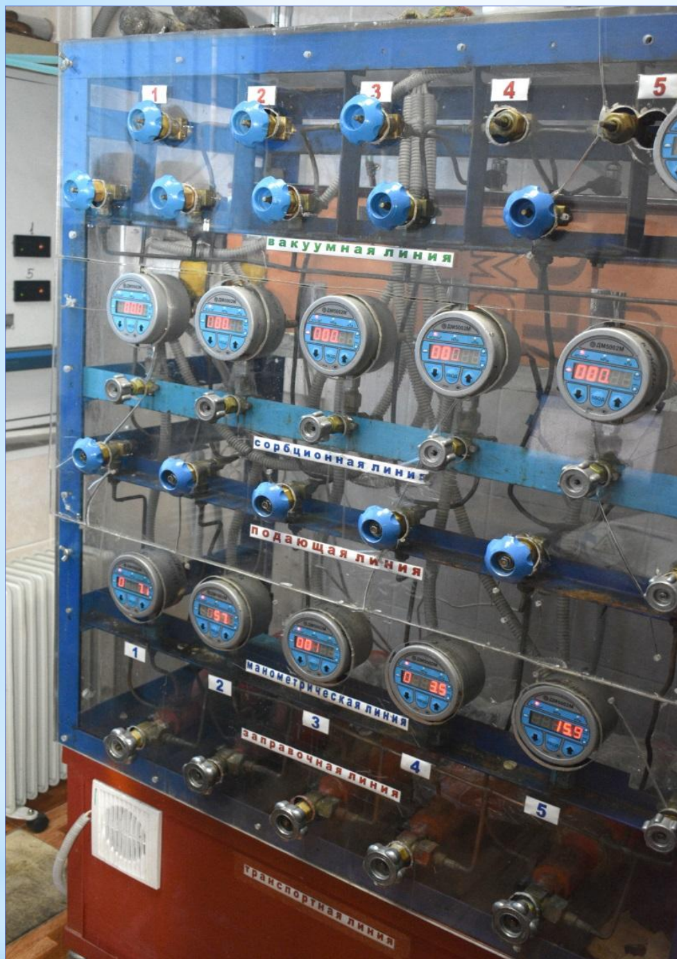
Сорбционная установка СУ-МК
